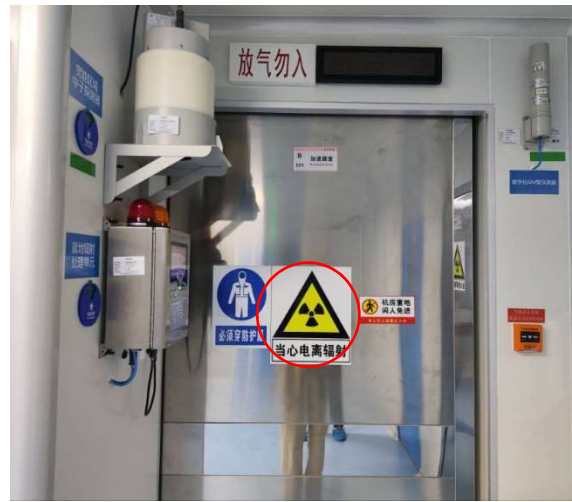
(b) 加速器室防护门当心电离辐射警告标志
