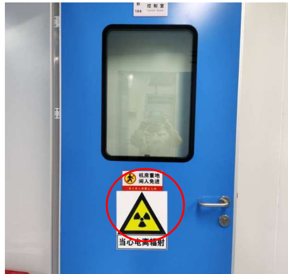
(d) 加速器控制室防护门当心电离辐射警告标志
